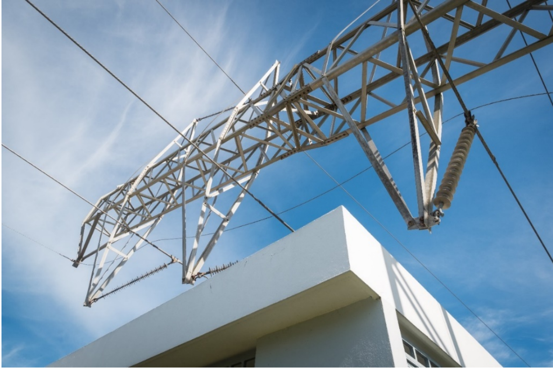
Figura 23 – Torre de distribución de madera y hormigón derribada en la Avenida 65 de Infantería en Puerto Rico
